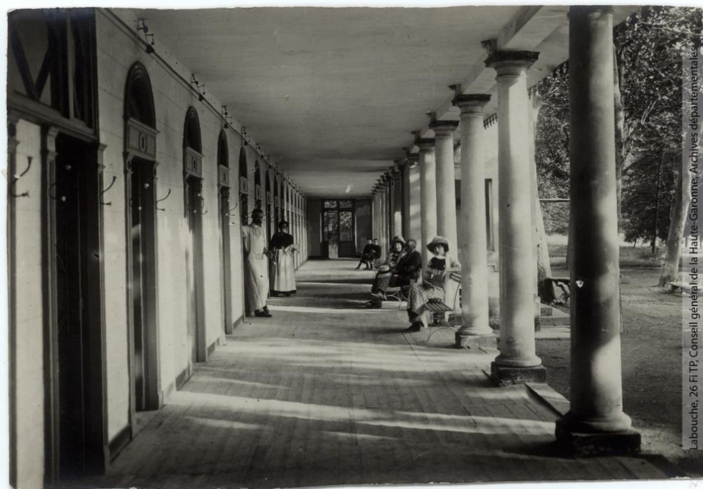
Établissement thermal de Ganties-les-Bains, Fonds Labouche, Arch. Départ. Haute-Garonne
